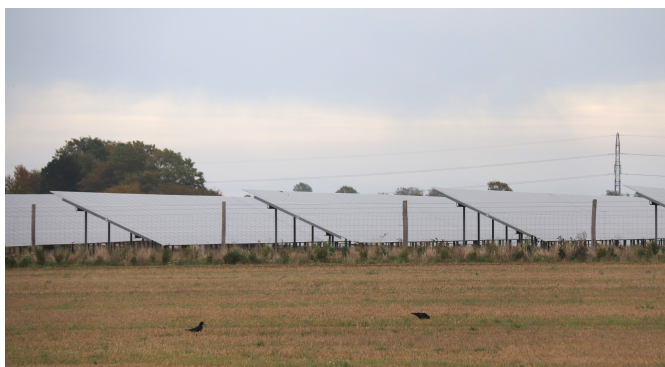
Solcelleanlæg ved Maglebjerg
